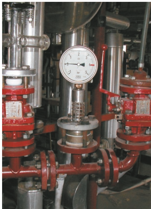
Přestavba robustního presostatu Asco Joumatic: spojením presostatu s přírubovým oddělovačem DN25 vznikl kompletně svařený, nerozebíratelný celek.
